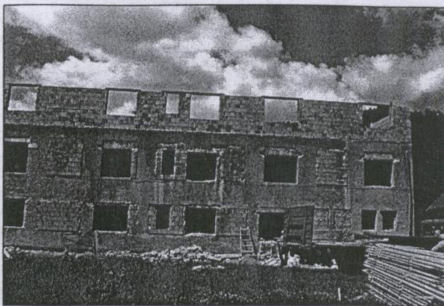
Výstavba nájomnej bytovky zo dňa 23.6.2005
